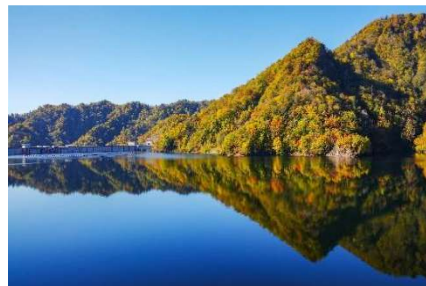
⑨ 定山溪ダム
