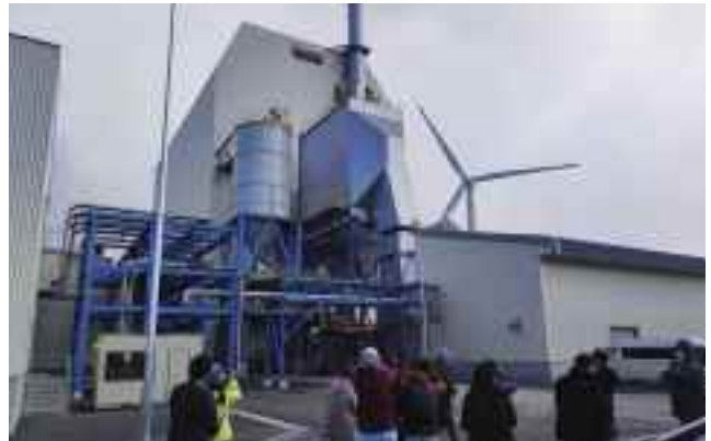
石狩市 バイオマス発電所と風力発電所
