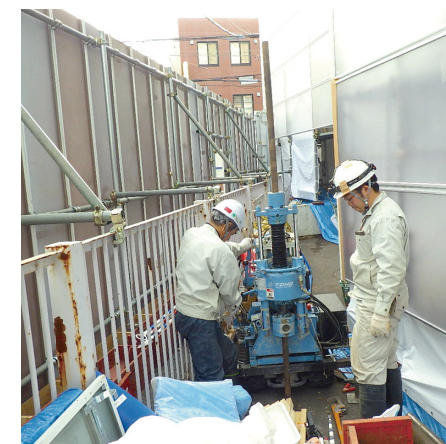
土壌汚染調査（ボーリング）の様子。法律で義務付けられた調査だけでなく、不動産取引や鑑定評価を目的とした依頼にも対応している。
