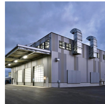
「ヒートリカバリーシステム（HRS）」を搭載した塗装ブース。従来のものに比べ大幅にCO 2 を削減でき、環境にも人にも優しい。
