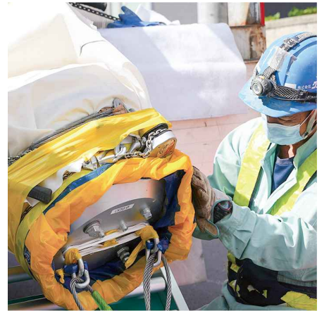
下水道管更生作業の様子。光や蒸気による管更生工法により、安全性が高まり工事時間も短縮し、技術は進歩が続いている。
