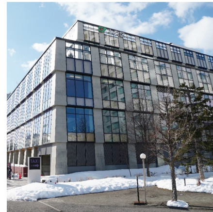
下水熱を利用した融雪・空調システムを採用した札幌市中央区複合庁舎。今後、さらなる導入拡大を目指している。
