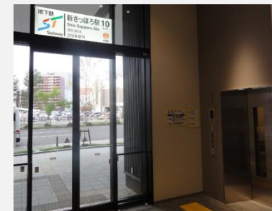
再開発を活用した地下鉄駅エレベーターの整備事例(新さっぽろ駅周辺地区I街区)
