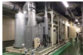
図 2-38 エネルギー センター
