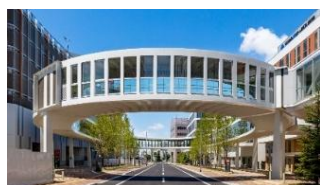
図 2-36 新札幌駅周辺地区Ⅰ街区アクティブリンク (空中歩廊)
