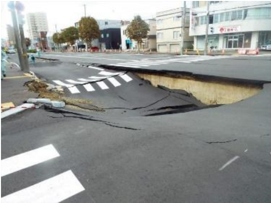
図 2-33 地震発生後の道路陥没のようす (平成30年北海道胆振東部地震) 資料：札幌市
