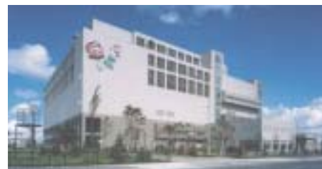
■最新技術を取り入れた環境にやさしい白石清掃工場
