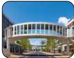
▲新さっぽろ駅周辺地区 I 街区 アクティブリンク/2022年
