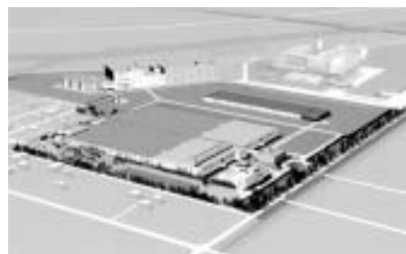
■高度処理方式を採用した東部処理場
