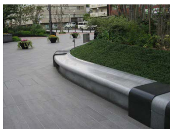
植栽柵の立ち上がり
