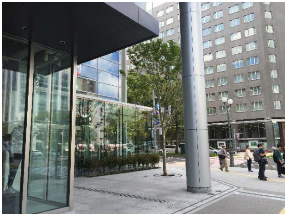
通り抜けができる敷地の角部分
