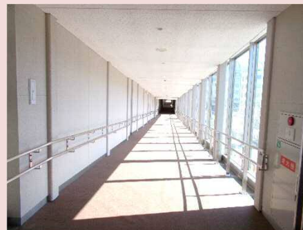
連絡通路の事例 (札幌市 北4東6地区)
