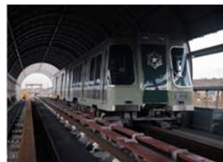
地下鉄建設（1970 年）
