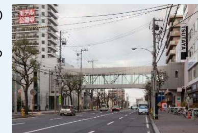
空中歩廊で接続されている事例 (札幌市 琴似4・2地区)
