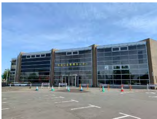
写真 2.3 もみじ台管理センター外観
