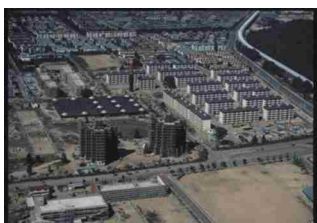
真駒内団地の造成(1972年)
