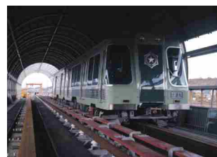
地下鉄建設(1970年)
