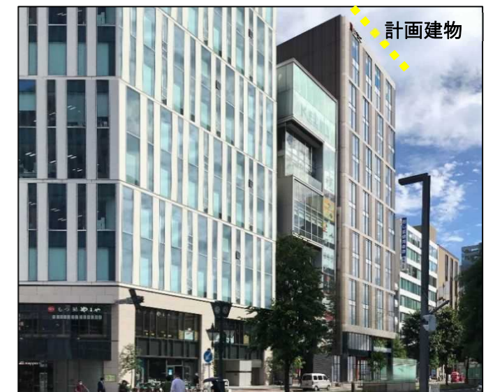
図2 札幌駅前通北側から計画建物を望む
