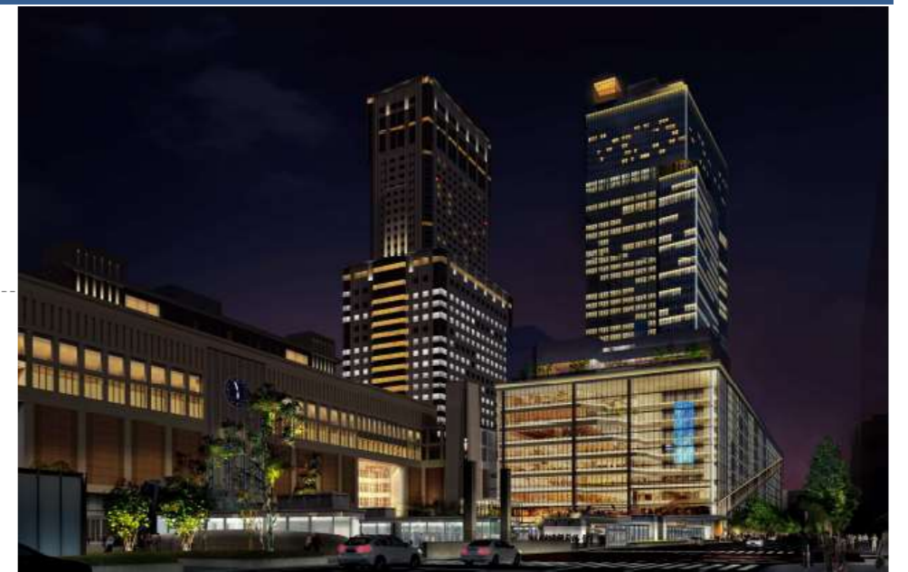
図12 敷地南西側から見た夜間の外観
