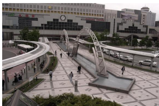
札幌駅北口駅前広場
