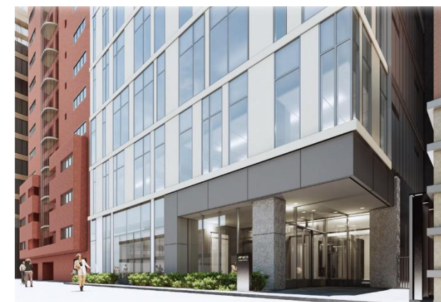
図7 エントランスの見え方
