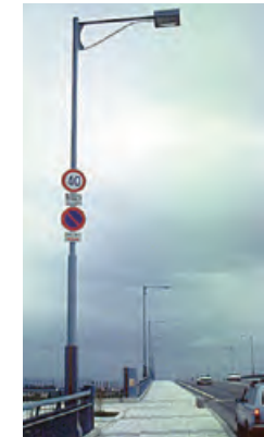
附帯工物と公共サインを一体化することですっきりとした橋上空間になっています
