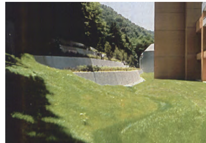
既存地形を生かし擁壁のボリュームを押さえるよう配慮(札幌市立大?)
