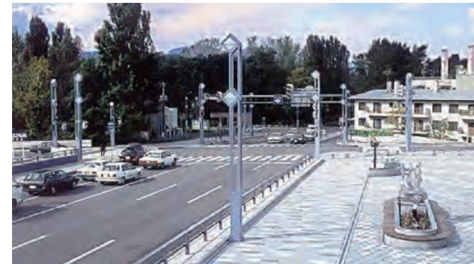
橋りょうと調和した附帯物のデザイン・色彩(幌平橋)
