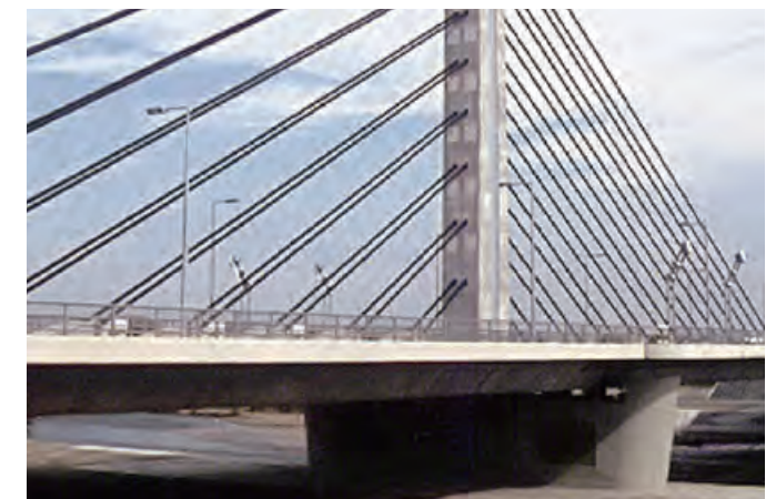
橋りょう全体の一体的なデザインに配慮(ミュンヘン大橋)
