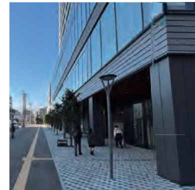
建築外装や舗装と馴染むシンプルな照明灯
