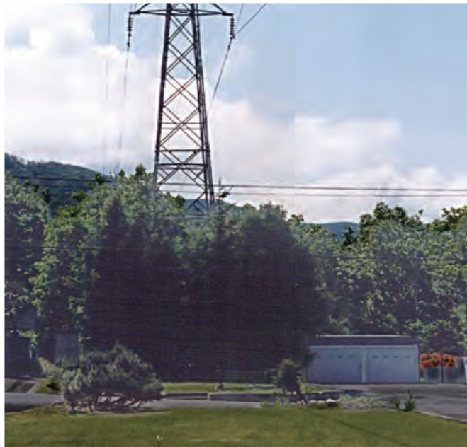
足元を緑化してスケール感を緩和しています
