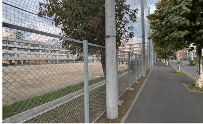
ネットフェンスの色をグレー系の落ち着いた色にすることで、周辺景観に溶け込んでいる(二条小学校)
