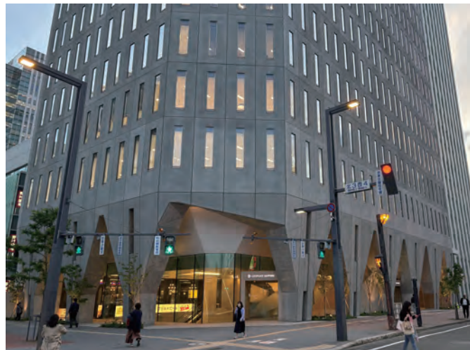
低層部に内部が見える印象的な開口部を設け、通りに対して開放的な低層部のデザイン(D-LIFEPLACE)
