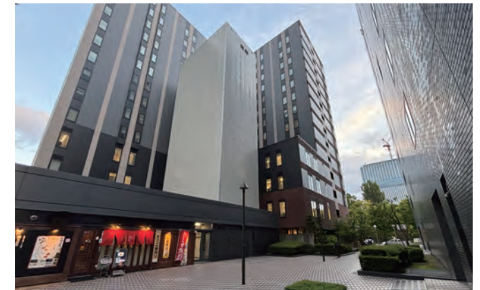
機械式駐車場を主要な通りから見えない位置に建物で囲むように配置し、中通りの低層部の賑わい用途を前面に配置することで駐車場が目立たないよう配慮(ソラリア西鉄ホテル)
