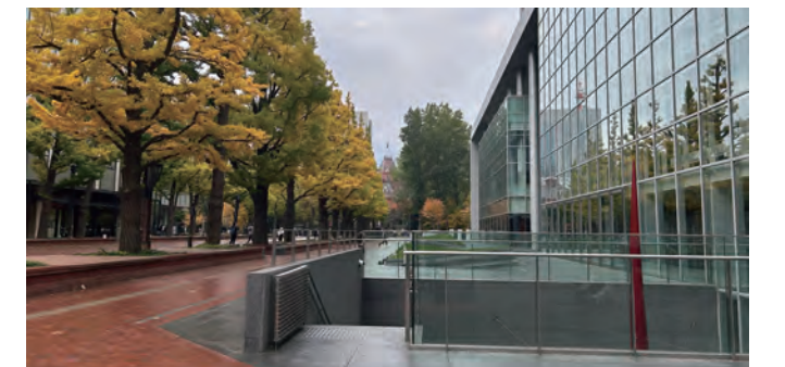
壁面を大きく後退させて赤レンガ庁舎やイチョウ並木の見え方に配慮(日生ビル)
