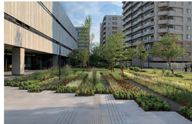
ストライプを基調とした建築外装デザインと合わせて、外構の植栽や舗装パターンもストライプをモチーフにトータルでデザイン(KDDIエポルバV/Altius Link)
