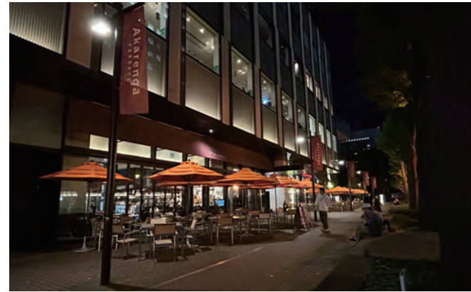
低層部に飲食店を設けオープンテラスを設けることで賑わいのある通りを演出(赤レンガテラス)
