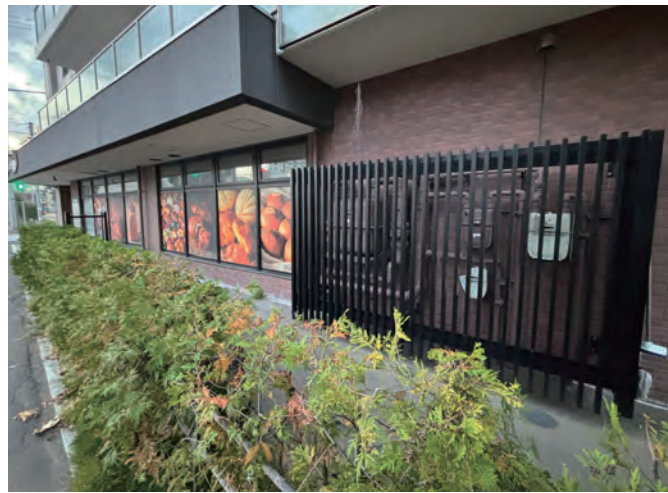
設備類を建築の外壁と同色にするとともに、ルーバーで目隠しをして手前を植栽帯とすることで目立たないよう工夫(中)南3条西14丁目
