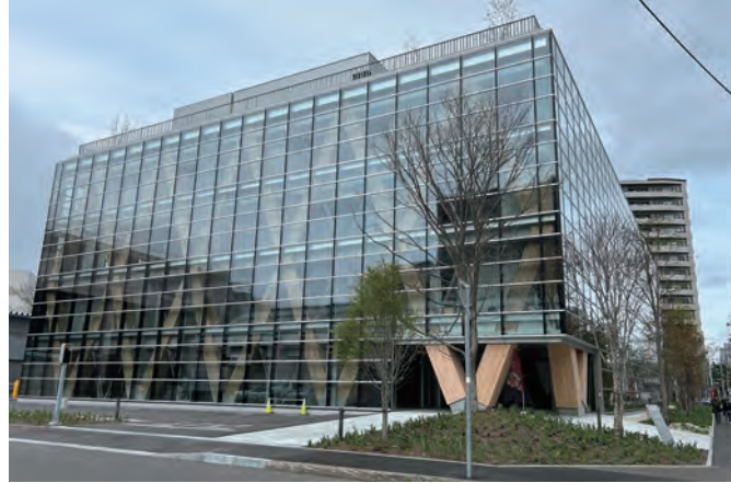
内部の特徴的な斜めの木柱を、全面ガラスの外装越しに見せる印象的な外観デザイン(エア・ウォーターの森)
