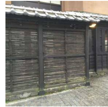
建築物の付帯設備を柵で目隠ししている例
