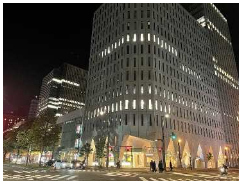
建築物から漏れ出る光などによる夜間景観
