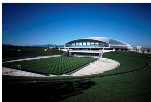
札幌ドーム (出典：株式会社札幌ドーム)
