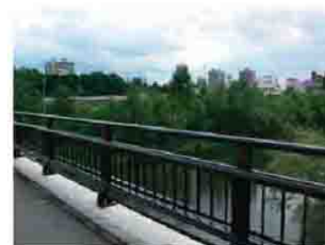
河川への見通しを確保するシンプルな高欄(南大橋)
