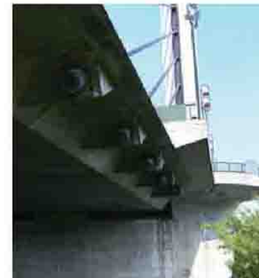
河川敷より見上げる(ミュンヘン大橋)
