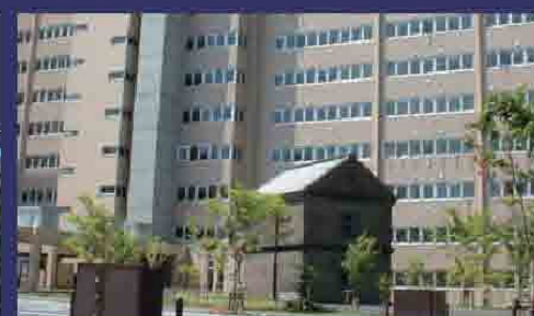
道営住宅光星第4団地
