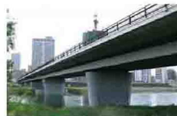
スッキリとした桁下(南大橋)
