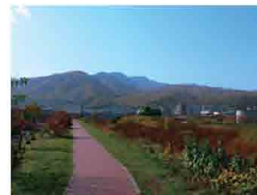
手廻山を望む堤防天端を遊歩道として整備している(中の川)
