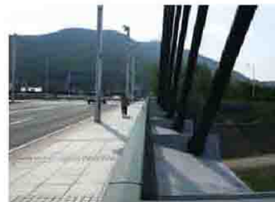
橋上より細部を見る(ミュンヘン大橋)
