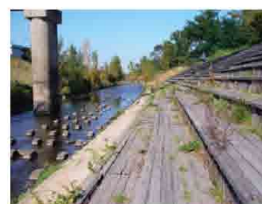
階段状のウッドデッキにより親水性が高く、水辺の景観に馴染んでいる護岸(琴似発寒川)
