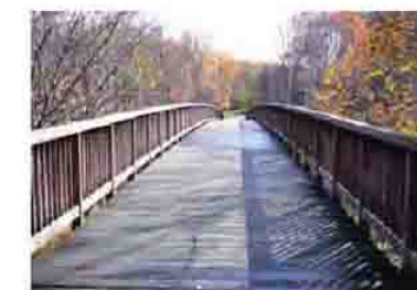
公園の自然景観に調和する木造橋(平岡公園内の木造橋)
