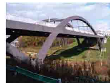
一体的にデザインされた橋(ボンノポロ橋)
