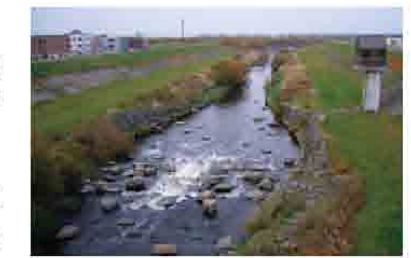
石と植生を織り交ぜ生態系の保全に配慮した護岸(月寒川)
