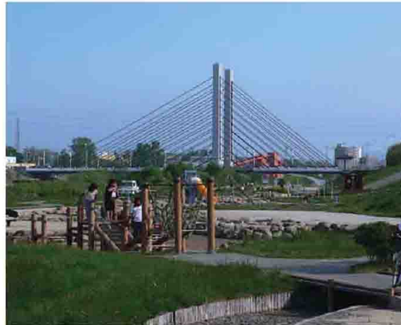
河川敷より見る(ミュンヘン大橋)
