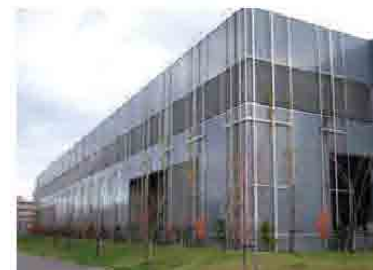
壁面緑化するため鷹の巻きつくポールを外壁に設置した駐車場(札幌コンベンションセンターの駐車場)
