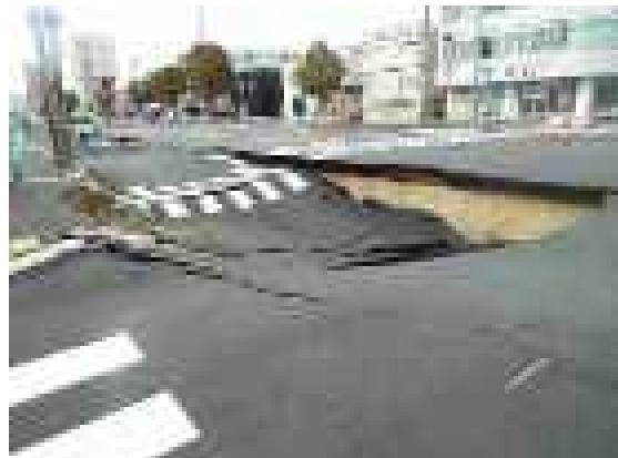
図 2-37 地震発生後の道路陥没のようす
