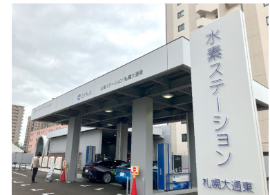
▲水素ステーション
