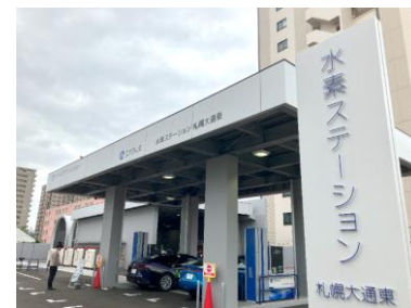
▲水素ステーション
