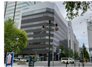
①建物全景
