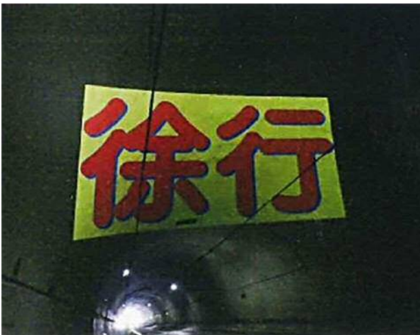
写真2 トンネル内上部にプロジェクターを利用し規制表示等を映し出した優良事例
