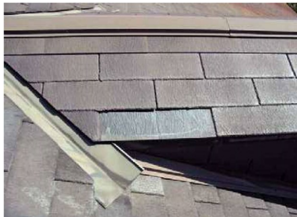
アスベスト含有住宅用化粧用スレート(屋根)
