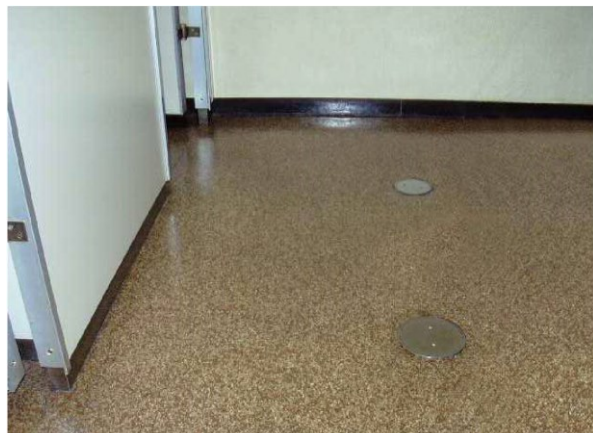
アスベスト含有ビニル床シート(床)
