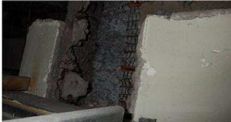
壁の中にクロシドライト（青石綿）が吹き付けられていた例（国マニュアルより）
