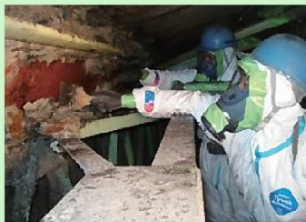
吹付け石綿の除去作業の様子
