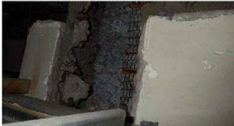
壁の中にクロシドライト（青石綿）が吹き付けられていた例（国マニュアルより）
