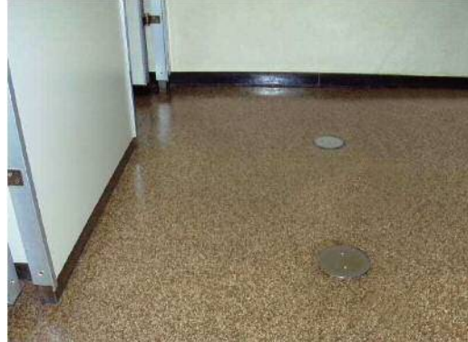
アスベスト含有ビニル床シート（床）
