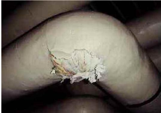
アスベスト含有配管保温材(配管)
