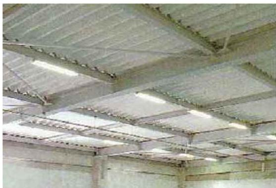
アスベスト含有屋根用折板断熱材(天井)
