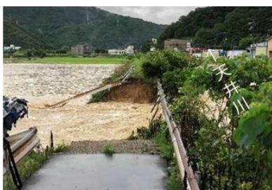
(出典) 水害レポート 2021 (国土交通省) 図 2-4 沼田川水系天井川の堤防決壊
