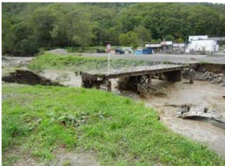
図 2-13 豪雨による橋の損壊
