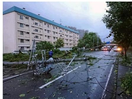
図 2-14 台風21号による電柱・樹木の倒壊
