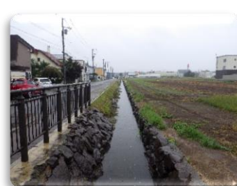
公園より上流部
