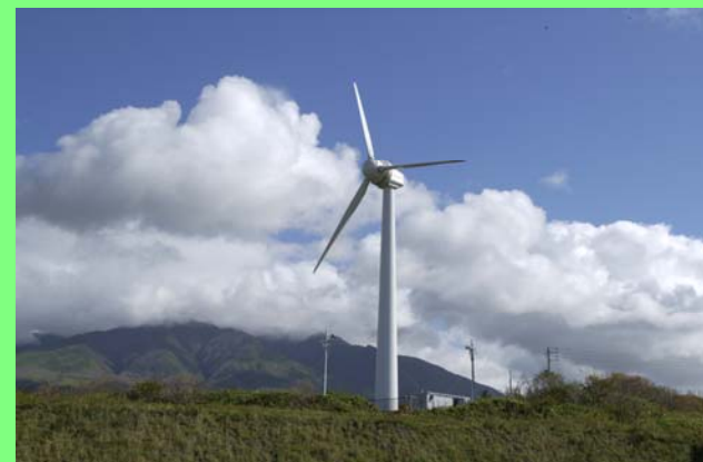
利尻カムイ発電所
