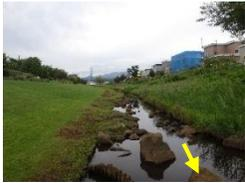
河道全域が整備されており、河道内に大石を配置して流れを変化させ、河岸には植物が繁茂しており、水生生物の生息場として利用されていた。
