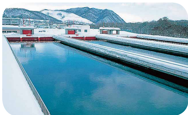
ちんさ池 ち 沈砂池
