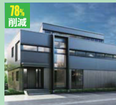
78%削減 株式会社シーテック 株式会社遠藤建築アトリエ
