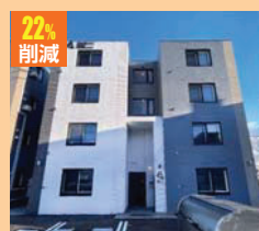
22%削減 大和ハウス工業株式会社北海道支店 有限会社JAM建築
