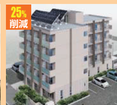
25%削減 株式会社中山組 有限会社ジャム建築
