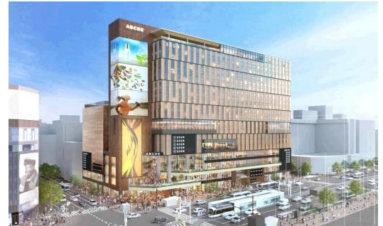
○(仮称)札幌すすきの駅前複合開発計画新築工事
