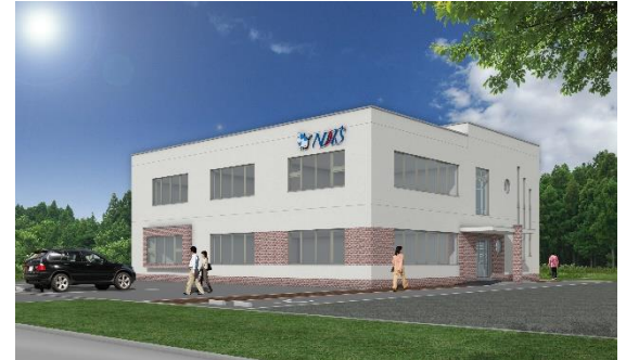
○日本動物特殊診断(株)事務所 新築工事
