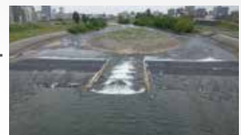
豊平川の床止に設置された魚道(写真中央)
