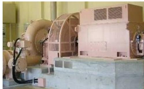
図20 小水力発電設備(藻岩浄水場)
