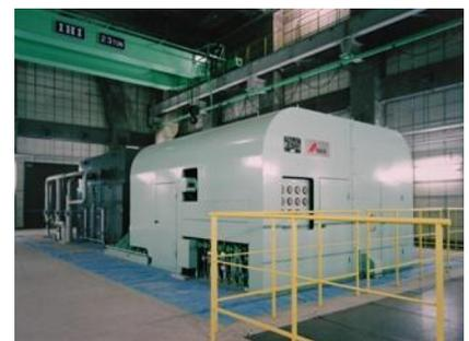
図11 蒸気タービン発電機
