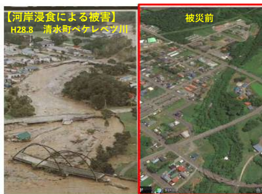
【河岸浸食による被害】 H28.8 清水町ベケレベツ川 出典：平成28年台風10号大雨災害報告書（平成29年7月 清水町）
