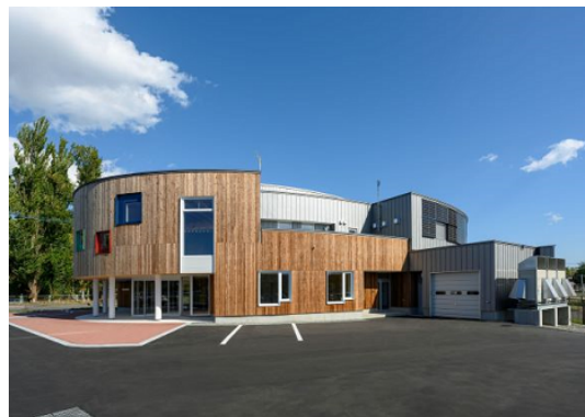
写真1 センター外観
